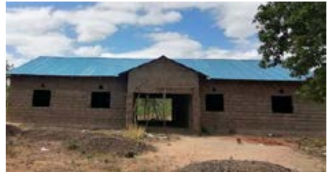
Das im Bau befindliche Verwaltungsgebäude der neuen Nzouni Primary School
